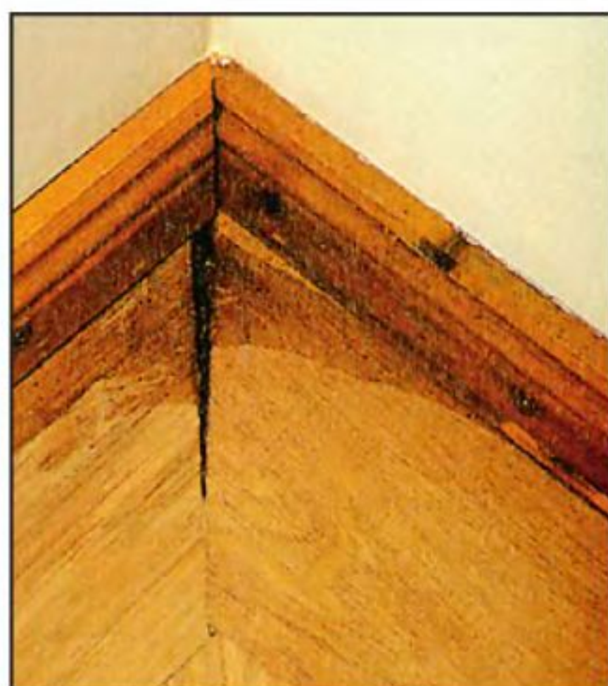
Вследствие коробления деревянных клёпок паркета под воздействием влаги или из-за деформирования основы в напольном покрытии могут образоваться щели.
