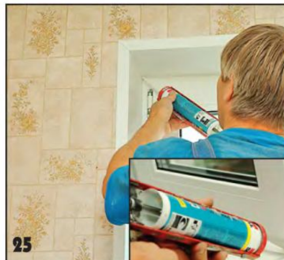
В завершение герметиком аккуратно заделывают все стыки (пластиковых плит облицовки откосов, декоративных профилей, подоконника и оконной рамы). Пока герметик не высох, следует быть осторожным, чтобы на шов не налипла пыль.
