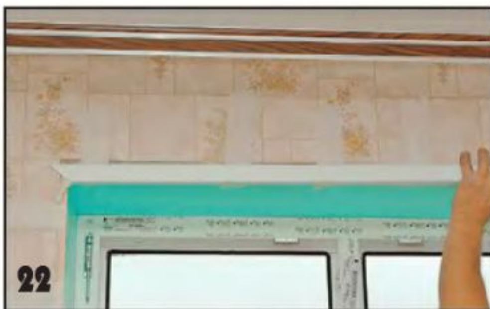
Концы профилей при подгонке обрезают для соединения «на ус».
