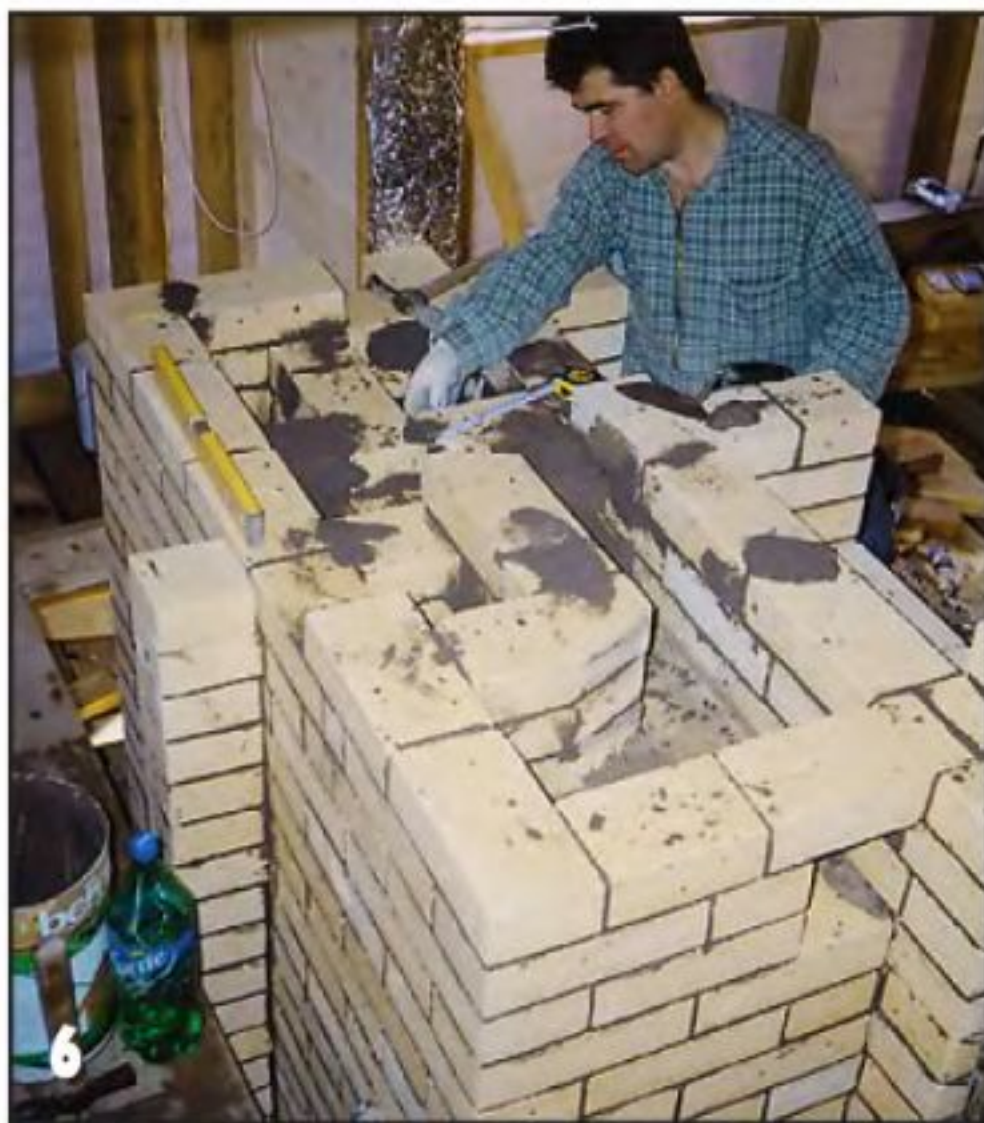
6 В дымоходах в местах изменения направления движения дыма наружные углы кирпичей опиливали, используя угловую шлифовальную машину с дисками по камню.
