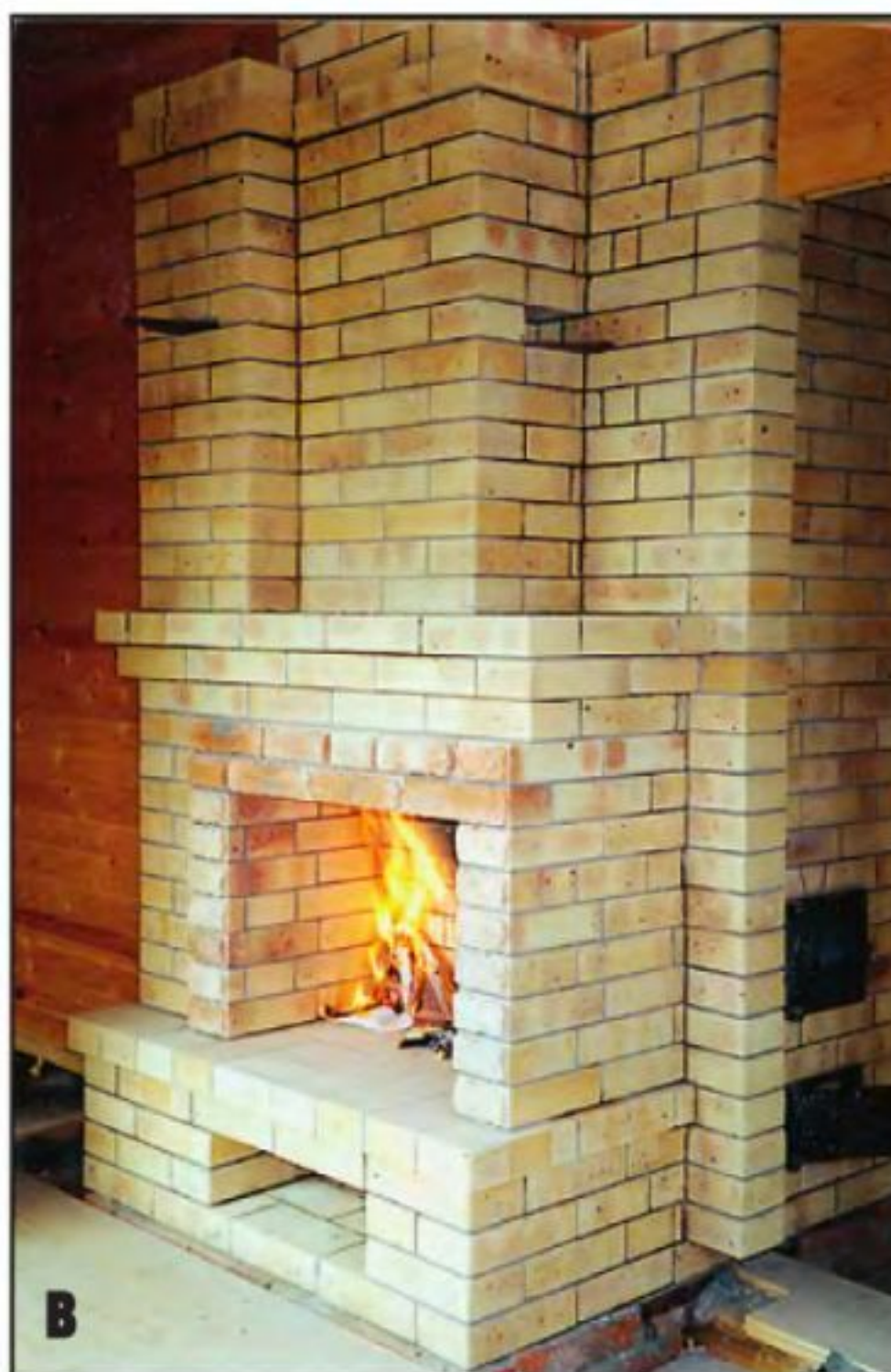
В Комбинированный очаг, выложенный из шамотного кирпича, гармонично вписывается в интерьер деревянного дома.
