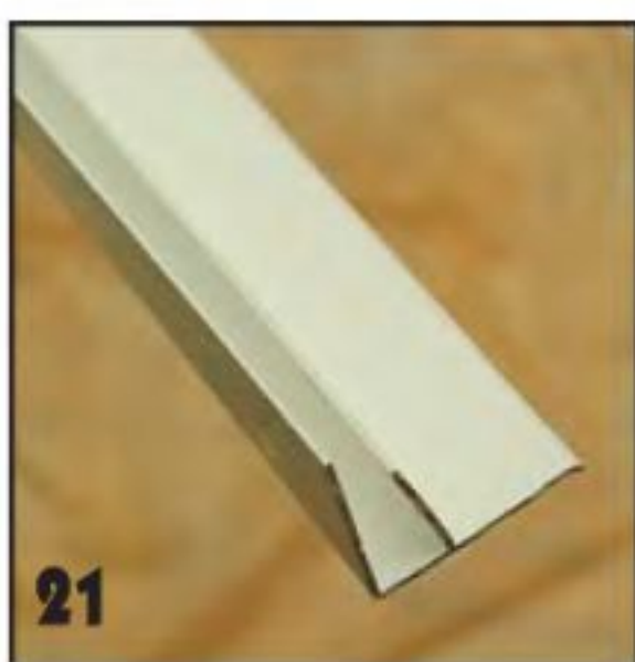
В завершение углы облицованных панелями откосов укрывают декоративными пластиковыми профилями.
