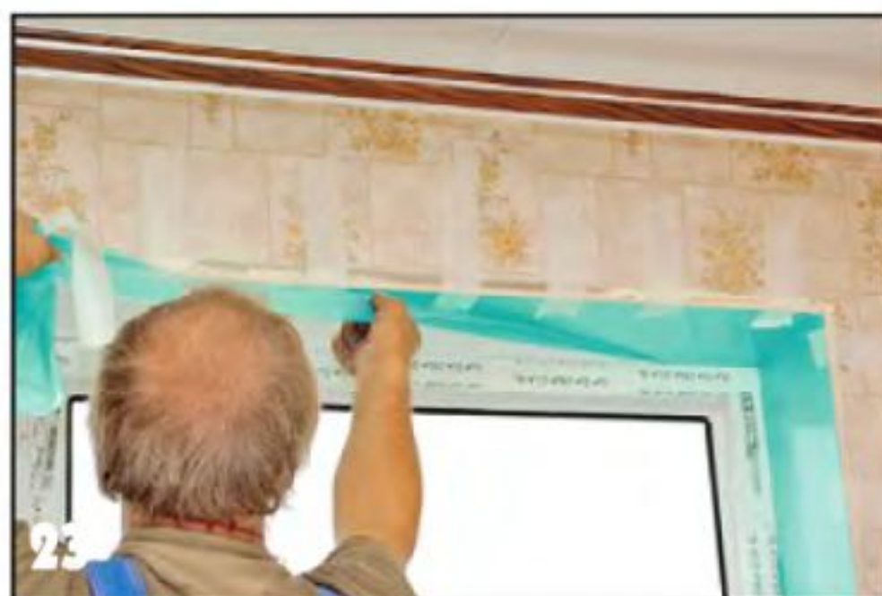
Перед монтажом декоративных профилей с панелей облицовки откосов снимают защитную плёнку.
