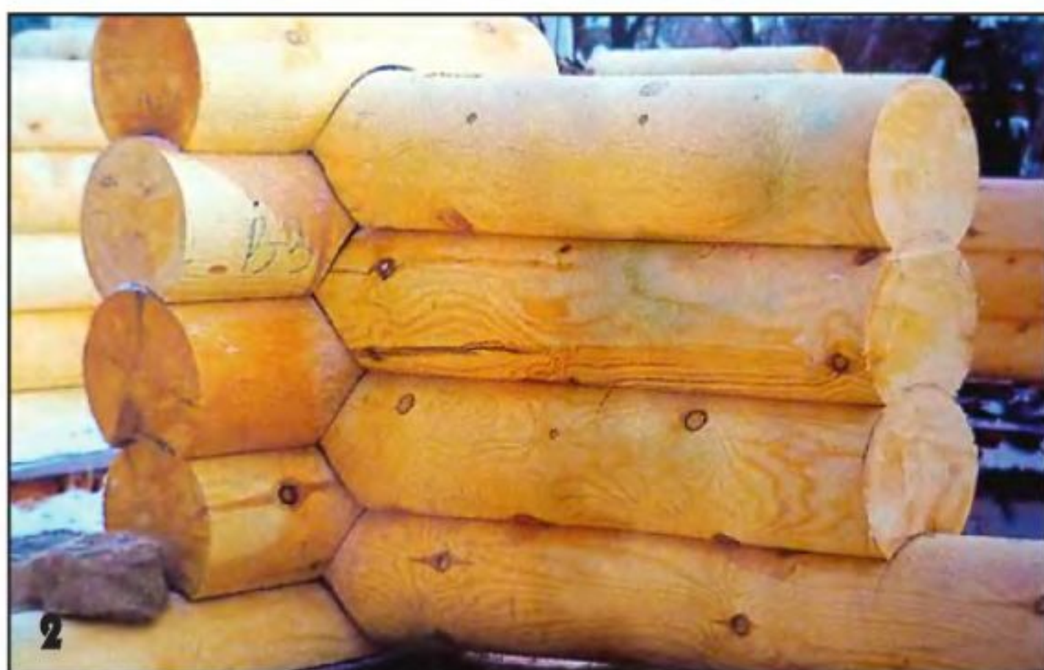
Стены дома, аккуратно сложенные из брёвен, можно не обшивать.
