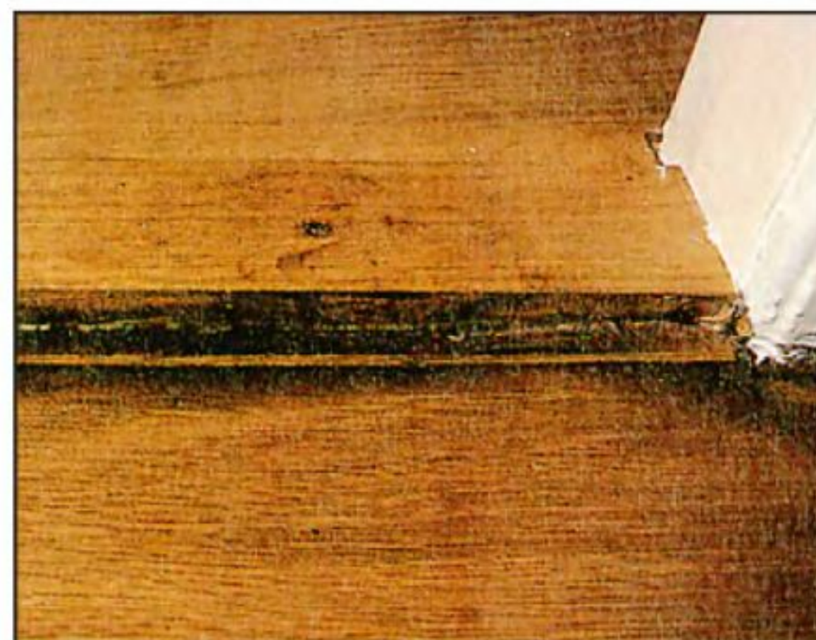
При использовании низкокачественной шлифовальной шкурки для окончательной обработки (а также при нарушении режимов обработки) паркета на его поверхности могут образоваться прижоги.
