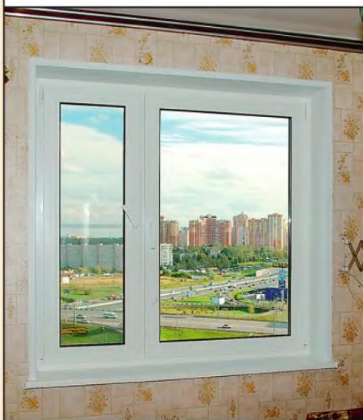
Теперь можно удалить защитную плёнку со стекла, с ПВХ-профилей и в полной мере насладиться видом нового окна.
