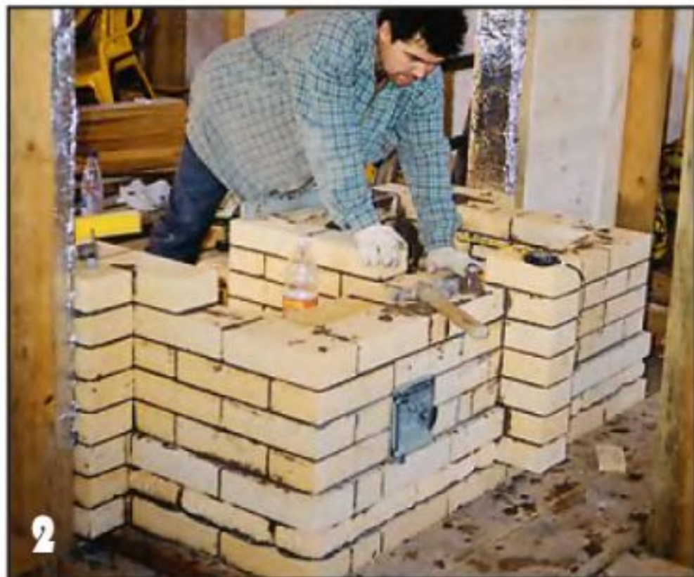
Каналы дымоходов заложили. Необходимо сохранить сечения и убрать излишки раствора со швов.
