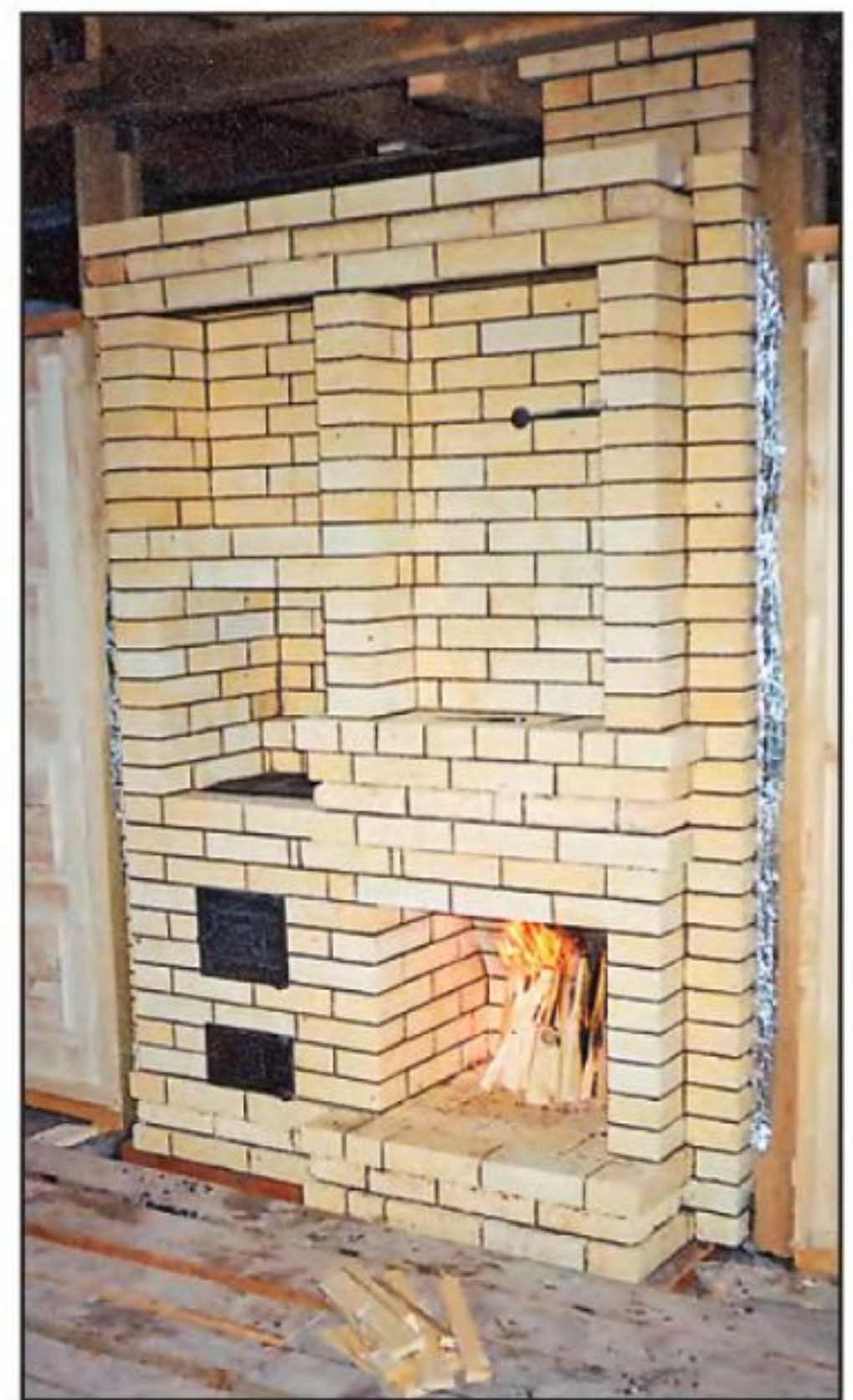
Контрольная топка камина показывает отличную тягу.
