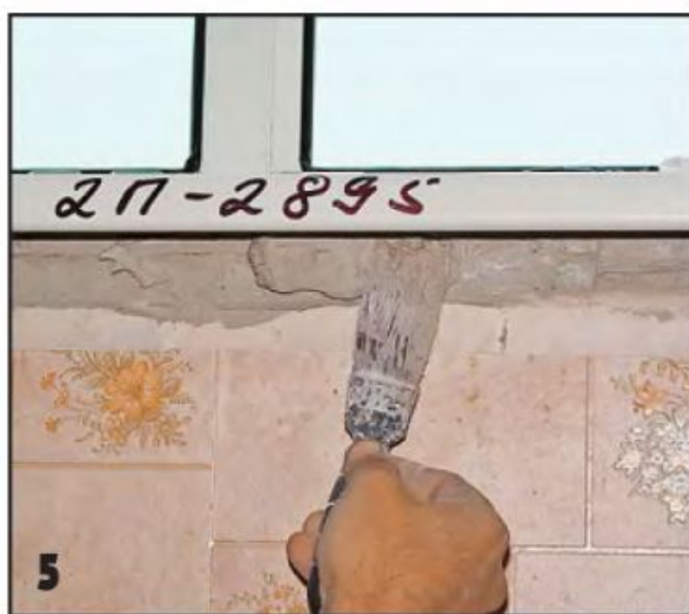
5 Когда монтажная пена затвердеет, оставшийся зазор под подоконником заполняют шпатлёвкой и выравнивают этот участок заподлицо со стеной.
