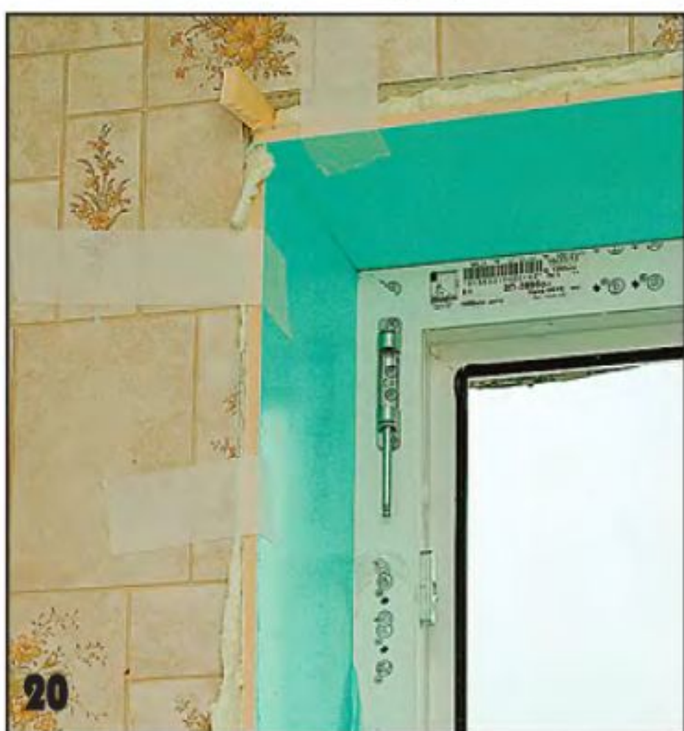
И боковую панель, выставленную по вертикали, сразу же фиксируют самоклеящейся лентой.
