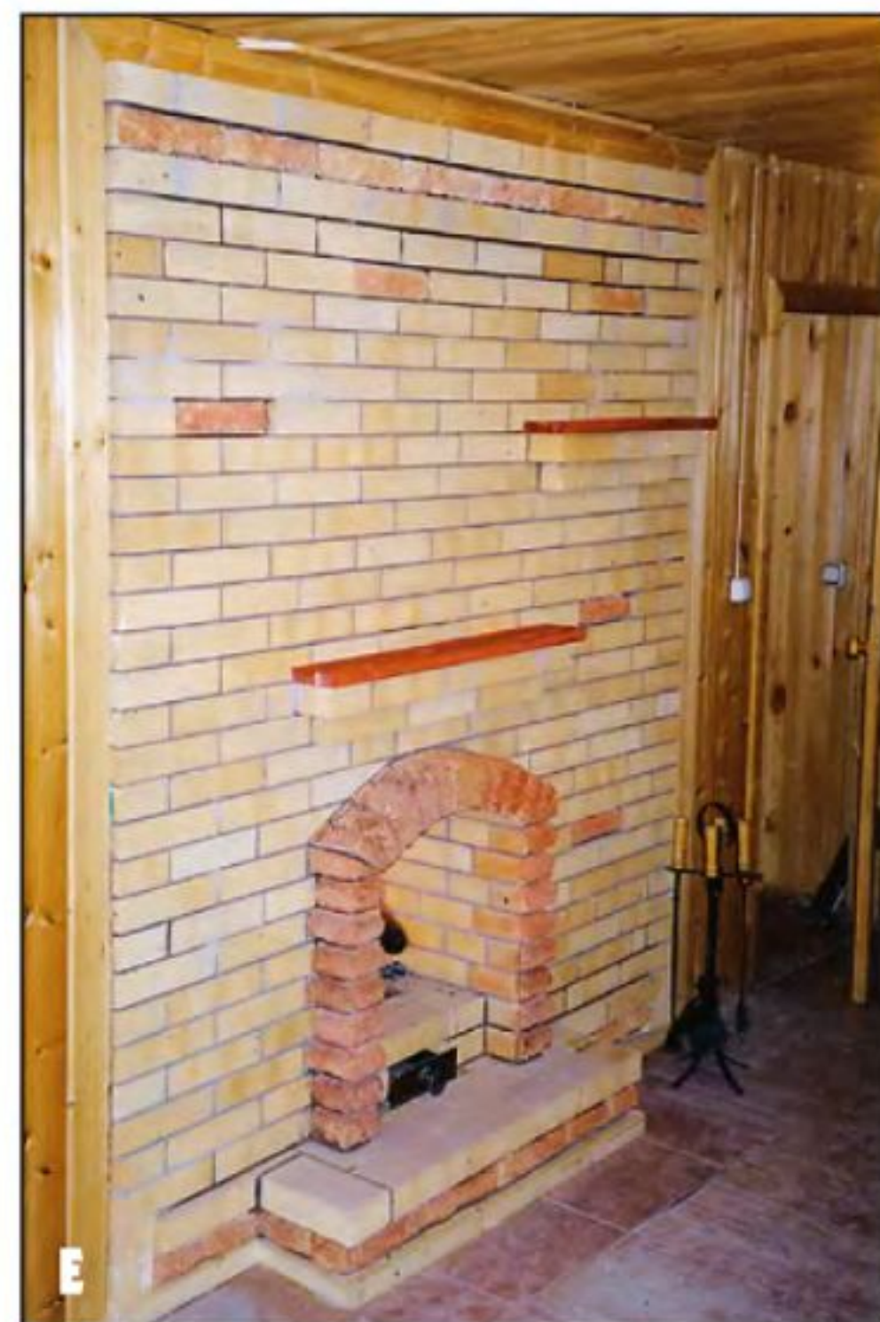
Топливник этого камина снаружи обрамлён аркой. Для большего контраста кладка арки выполнена из того же шамотного кирпича, но подкрашенного морилкой на водной основе. Необычная каминная полка дополнена ещё одной, расположенной чуть выше и правее.
