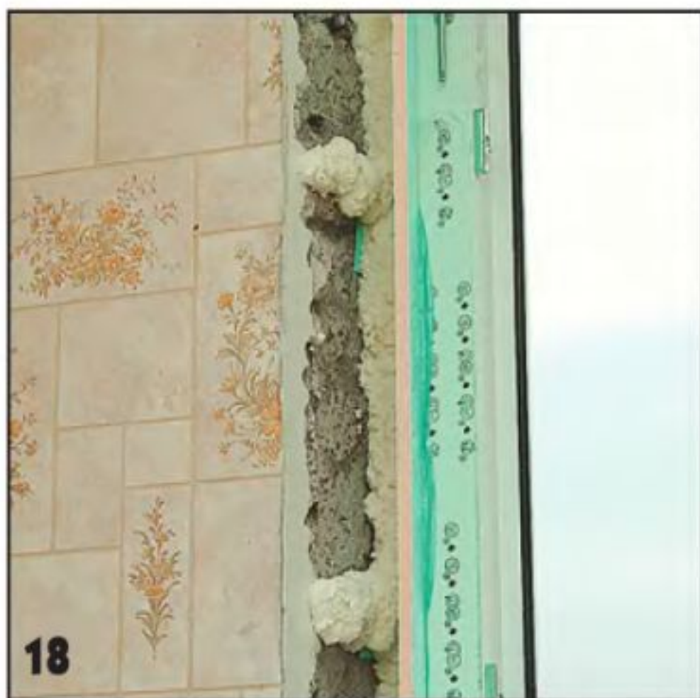
На боковой откос наносят валики монтажной пены и,...
