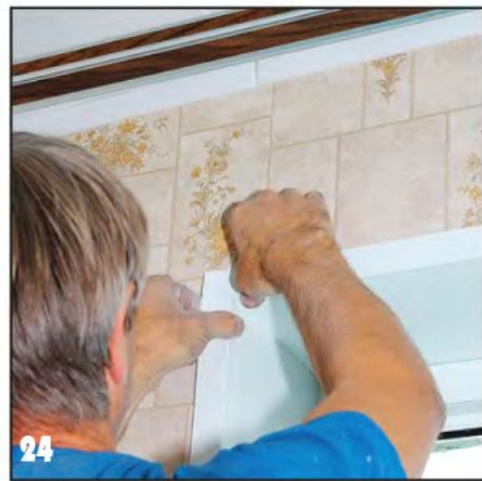
Декоративные профили по углам откосов приклеивают герметиком.
