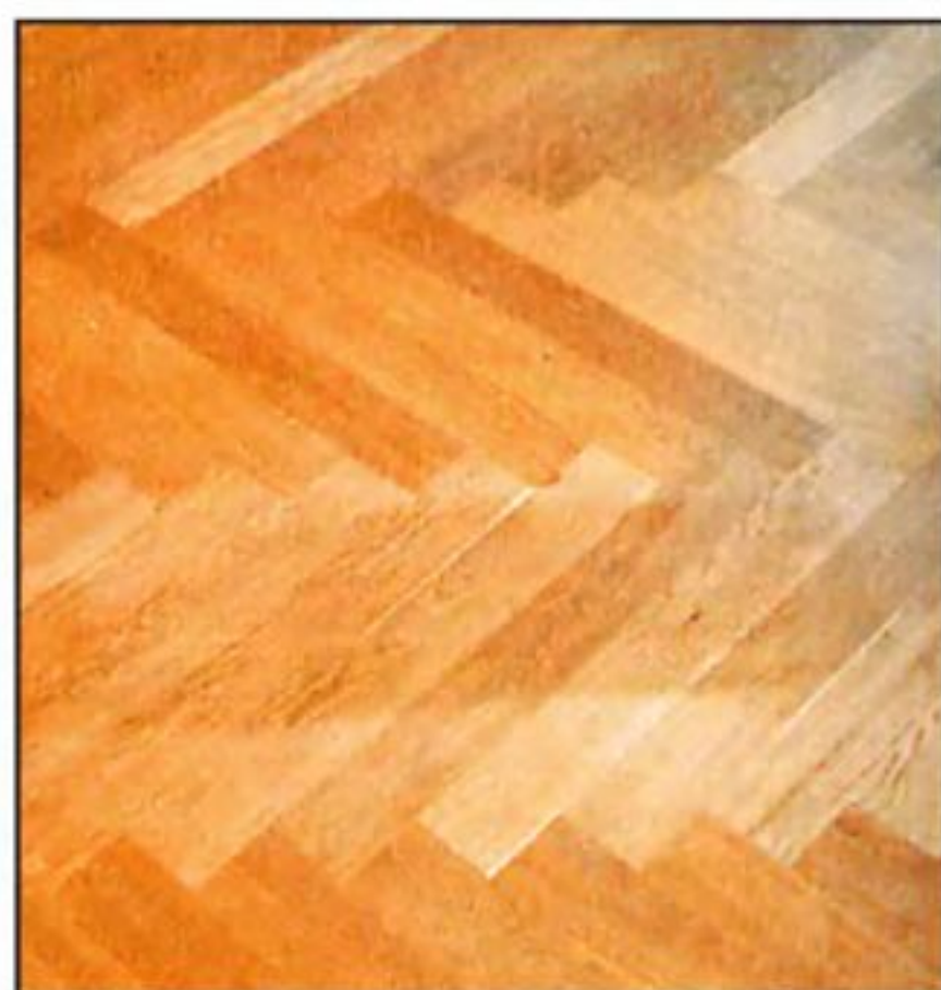
«Волны» (углубления) на полу образуются при неравномерном шлифовании паркета.
