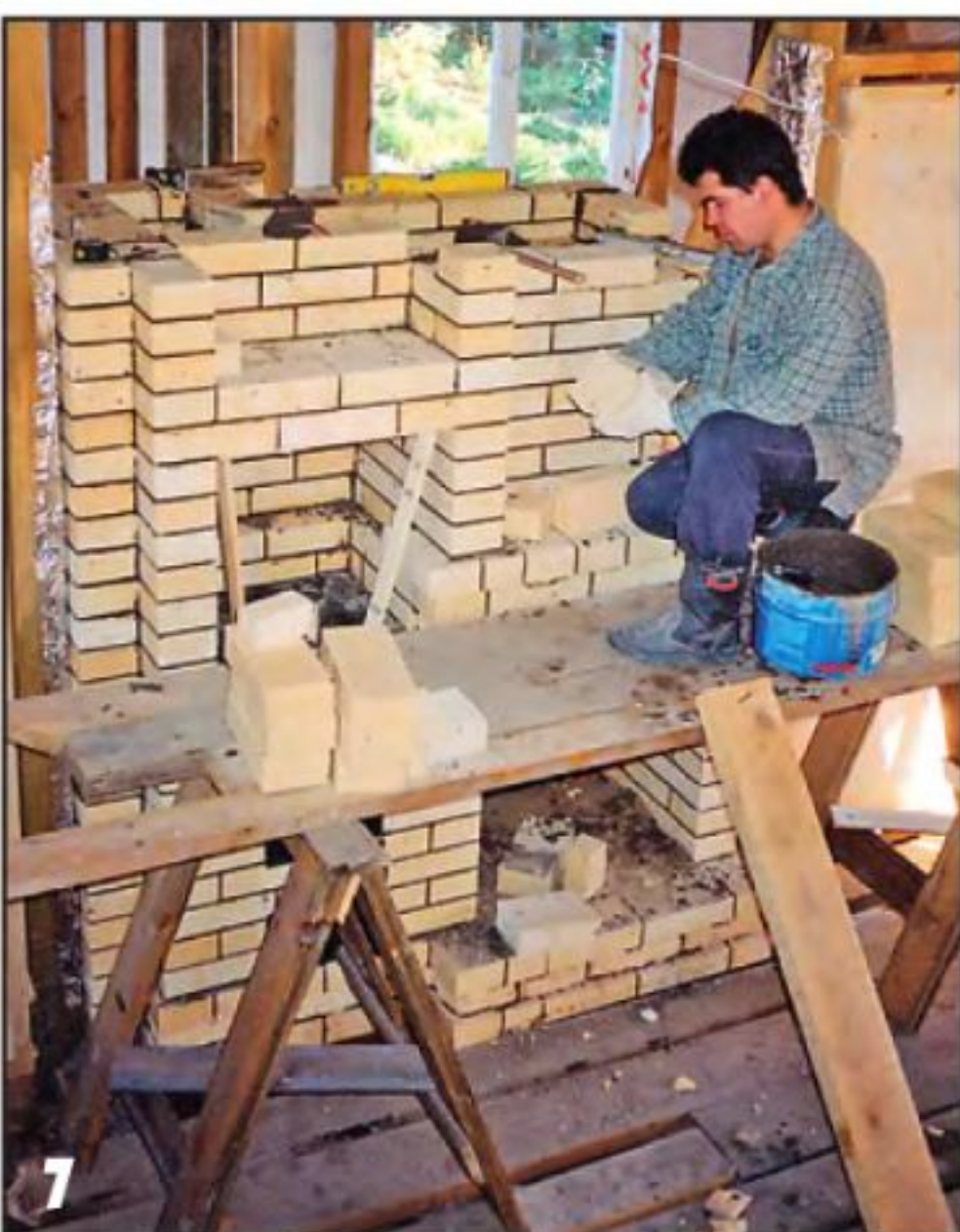
7 Кирпичи со сколами использовали для кладки внутри очага.
