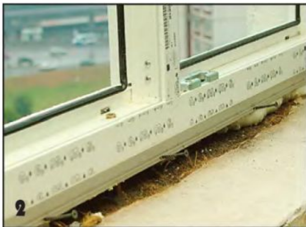
2 В нижнюю часть подставочного профиля вкручивают саморезы в качестве опоры тыльной стороны подоконника.
