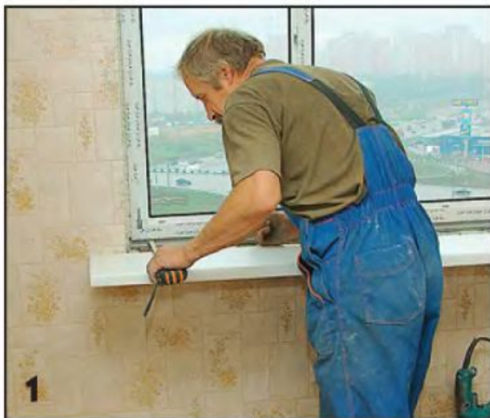
1 Чтобы подогнать подоконник по месту, делают необходимые замеры.
