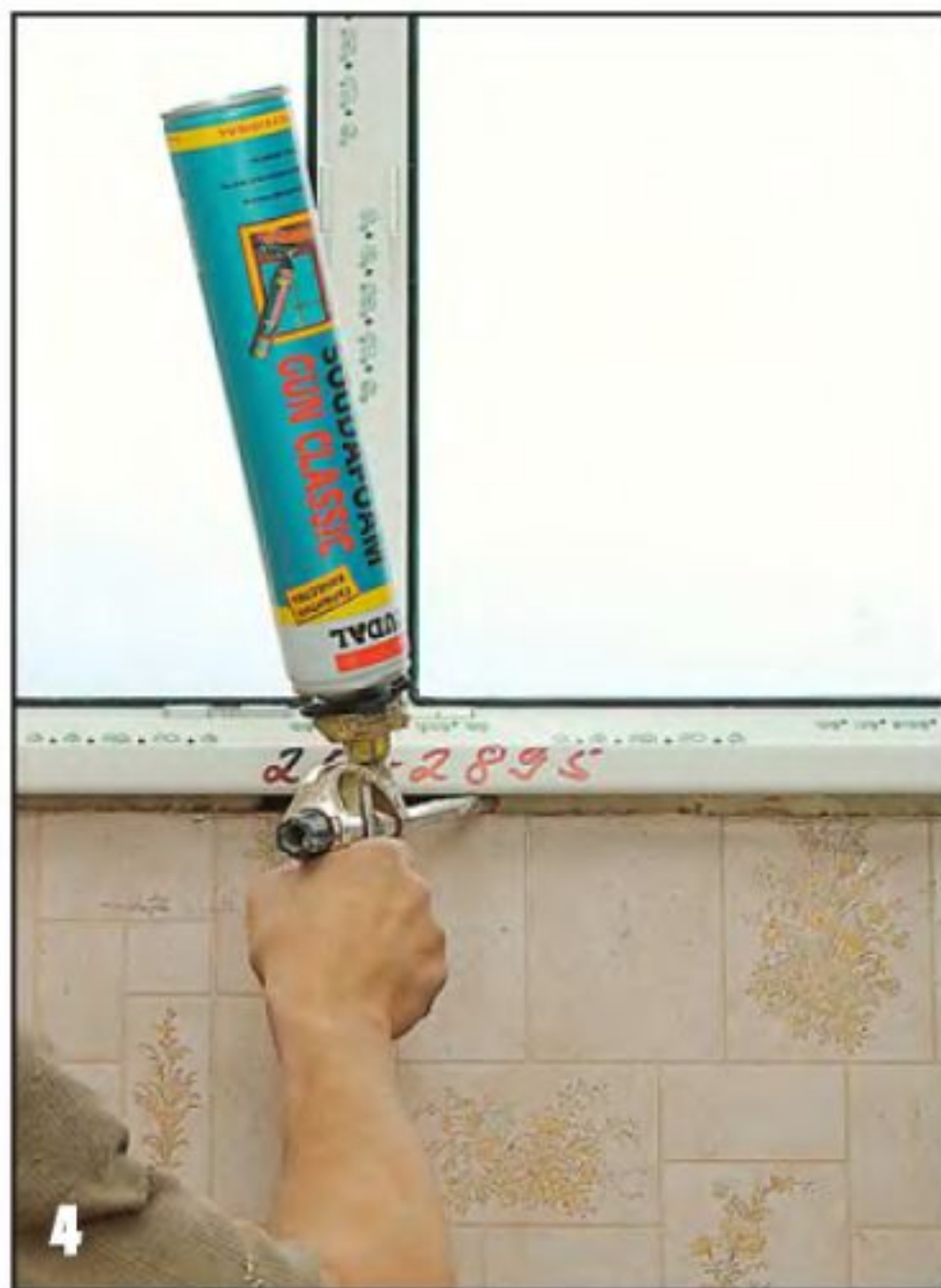
4 Зазор между подоконником и оконным проёмом заполняют монтажной пеной.
