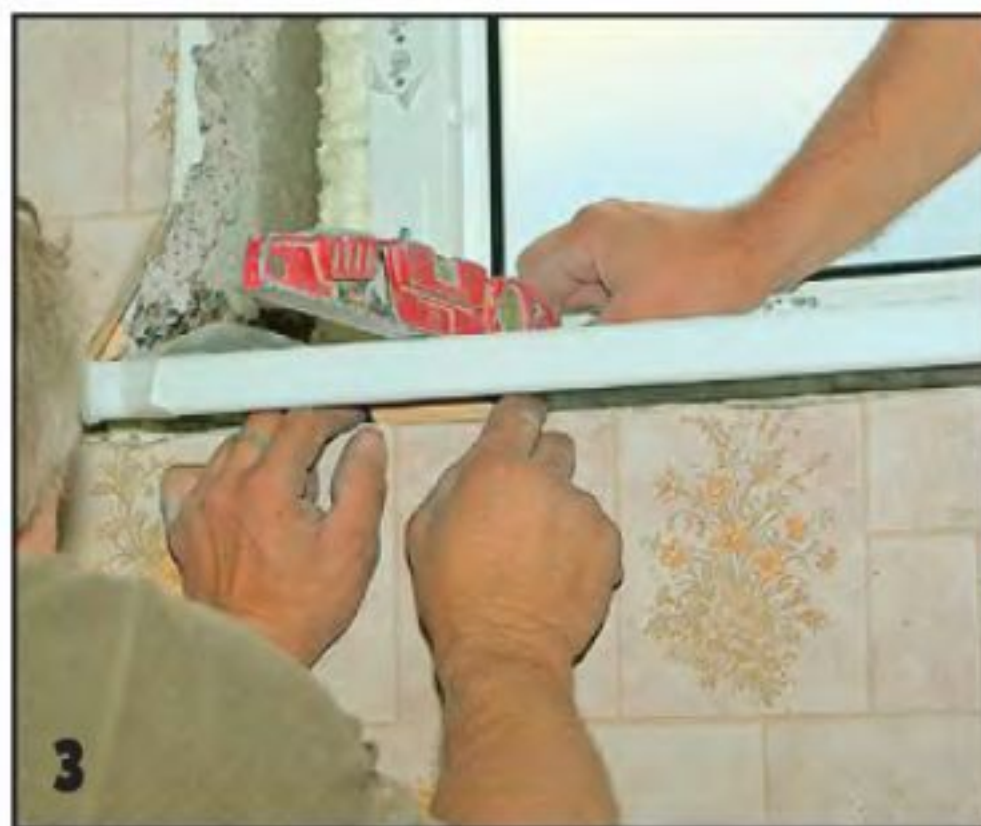
3 Укладывают подоконник на место и по уровню выставляют его с помощью разной толщины подкладок.
